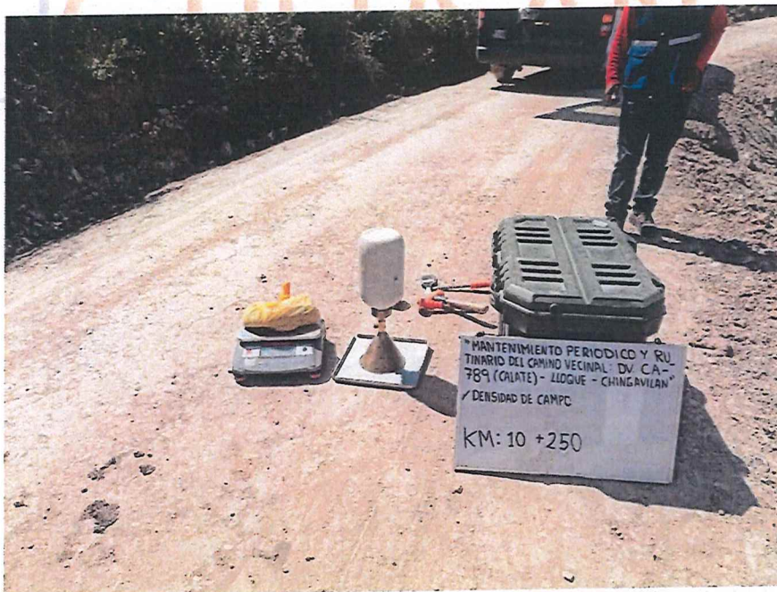
FIGURA N° 42. Ensayo de Densidad de Suelo en Campo. Progresiva 10 + 250 (Método del cono de arena).
