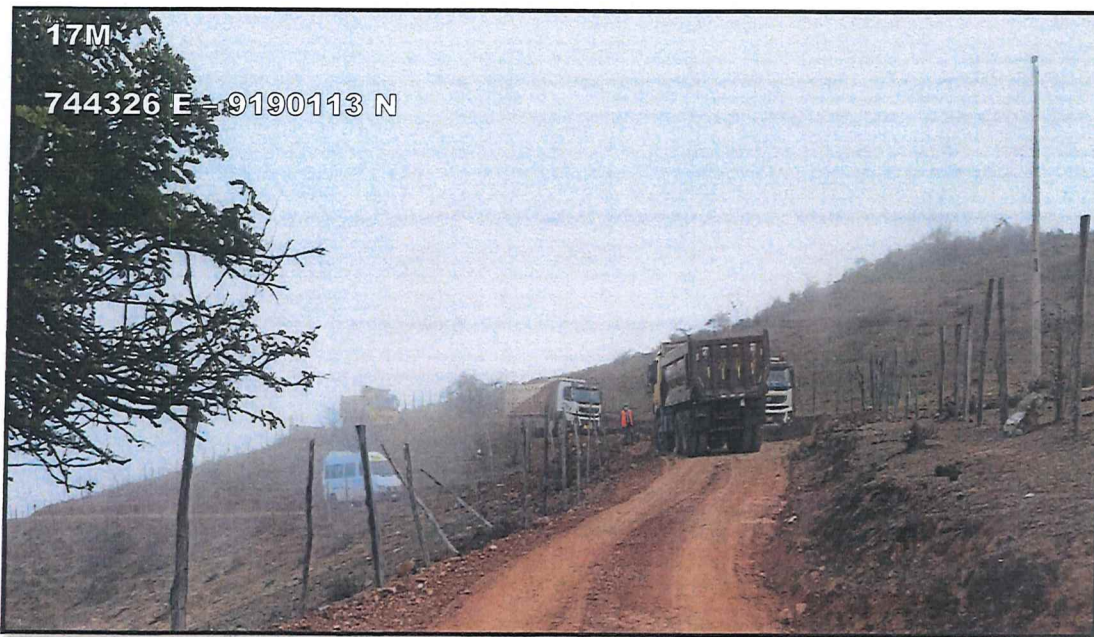
FOTO N° 11: Tendido de material granular al camino vecinal con volquetes.
