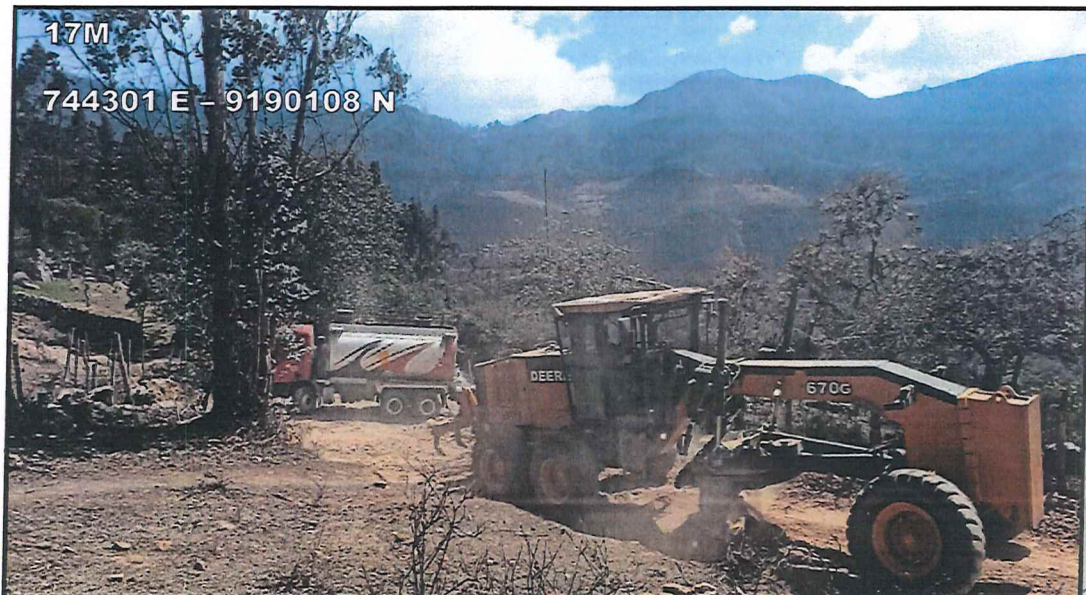
FOTO Nº 06: Perfilado de la Superficie de rodadura.
