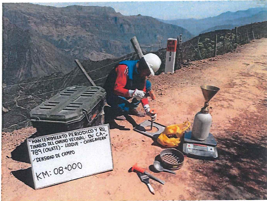
FIGURA N° 33. Ensayo de Densidad de Suelo en Campo. Progresiva 08 + 000 (Método del cono de arena).
