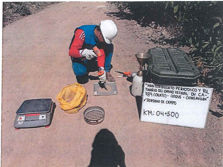
FIGURA N° 19. Ensayo de Densidad de Suelo en Campo. Progresiva 04 + 500 (Método del cono de arena).
