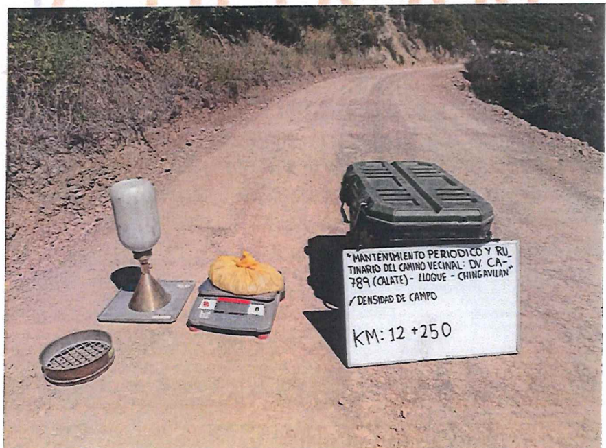
FIGURA N° 50. Ensayo de Densidad de Suelo en Campo. Progresiva 12 + 250 (Método del cono de arena).
