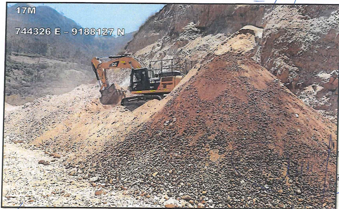
FOTO N° 08: Extracción y Acumulación de material granular.
