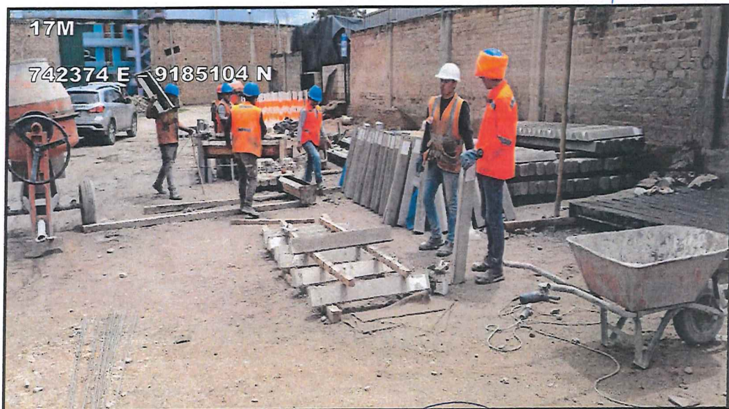
FOTO N° 16: Construcción de hitos kilométricos.
