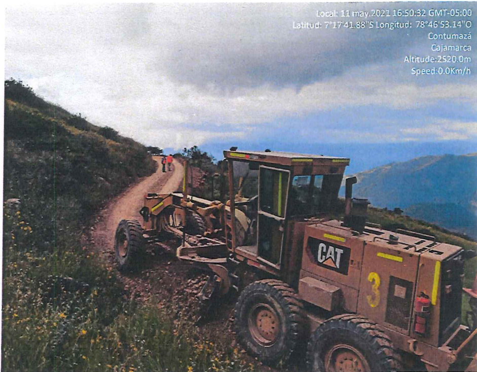
Ilustración 7. Conformación de la capa de afirmado.
