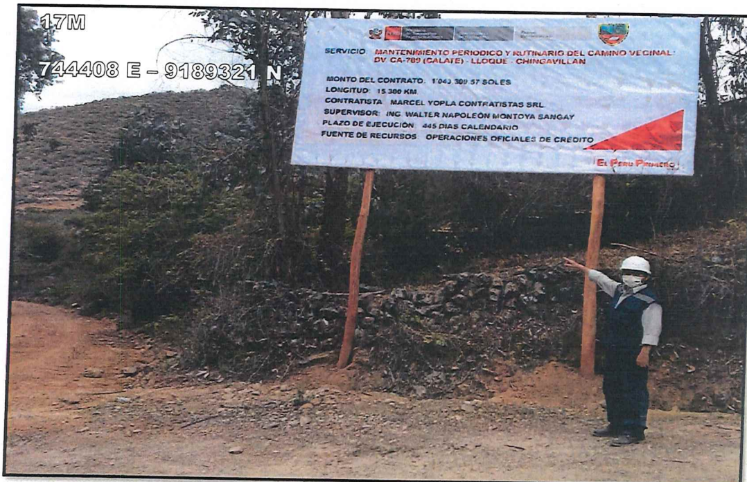
FOTO N° 01: Colocación de cartel informativo de servicio.
