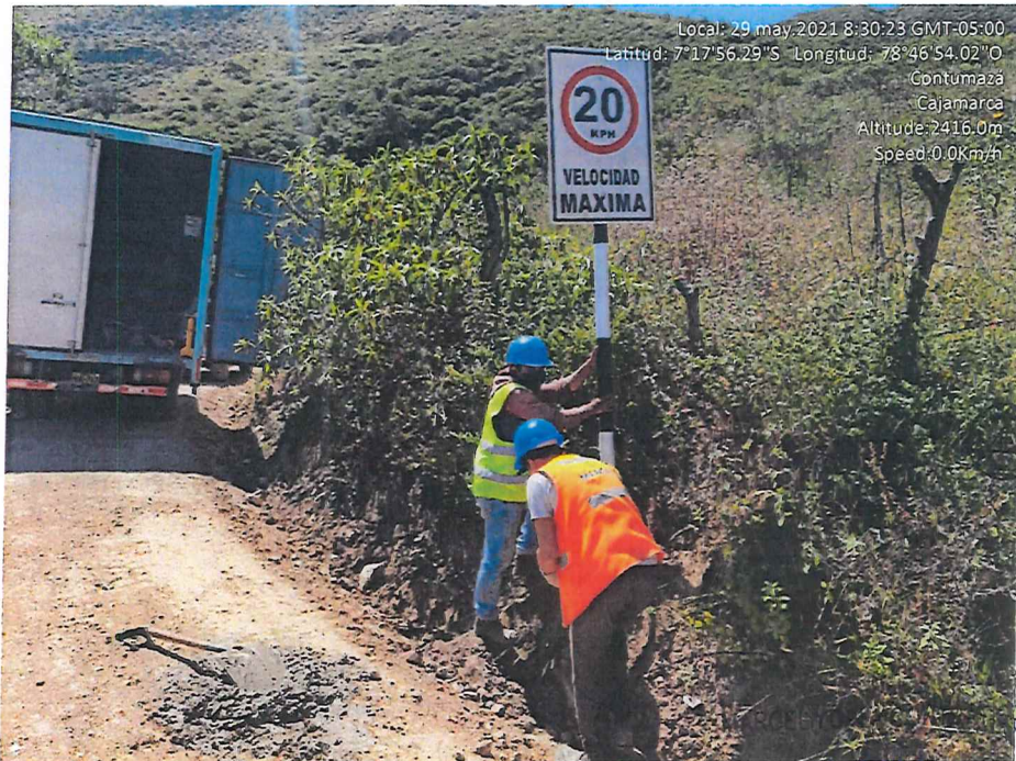
Ilustración 16. Colocación de la señal reglamentaria.
