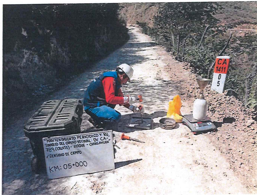
FIGURA N° 21. Ensayo de Densidad de Suelo en Campo. Progresiva 05 + 000 (Método del cono de arena).
