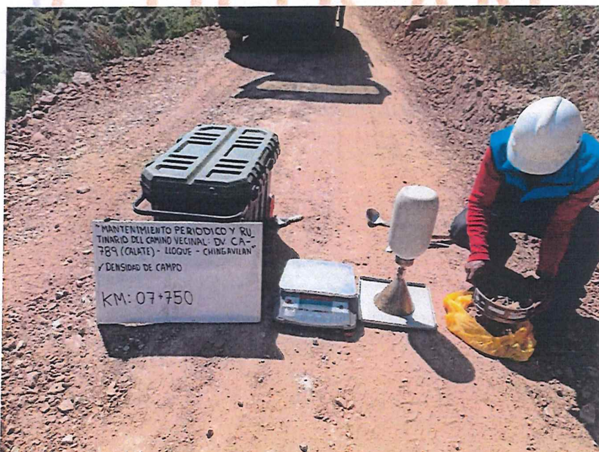
FIGURA N° 32. Ensayo de Densidad de Suelo en Campo. Progresiva 07 + 750 (Método del cono de arena).
