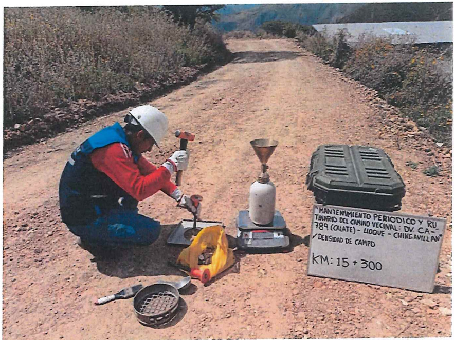
FIGURA N° 63. Ensayo de Densidad de Suelo en Campo. Progresiva 15+ 300 (Método del cono de arena).
