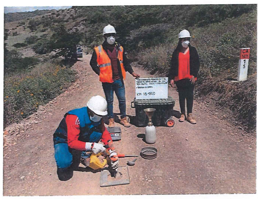
FIGURA N° 61. Ensayo de Densidad de Suelo en Campo. Progresiva 15 + 000 (Método del cono de arena).
