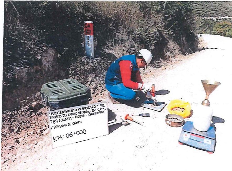
FIGURA N° 25. Ensayo de Densidad de Suelo en Campo. Progresiva 06 + 000 (Método del cono de arena).
