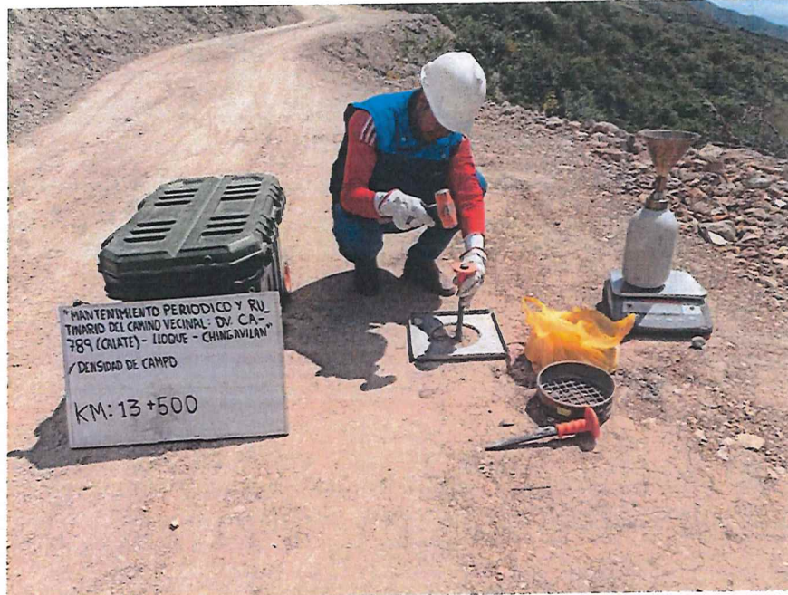
FIGURA N° 55. Ensayo de Densidad de Suelo en Campo. Progresiva 13 + 500 (Método del cono de arena).
